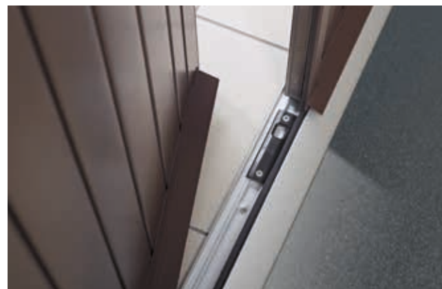
Seuil aluminium standard. Panneau avec jet d'eau filant en partie basse (ouverture intérieure).
