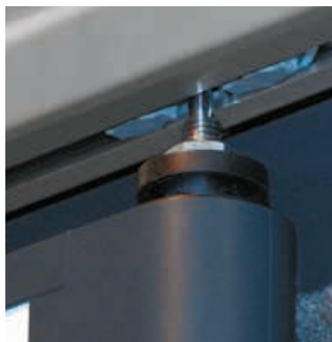
Galet emprisonné sur rail anti-déraillement.
