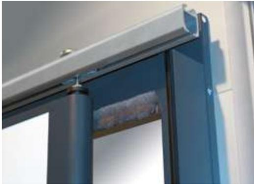
Précadre aluminium laqué + joint brosse et joint caoutchouc d'étanchéité
