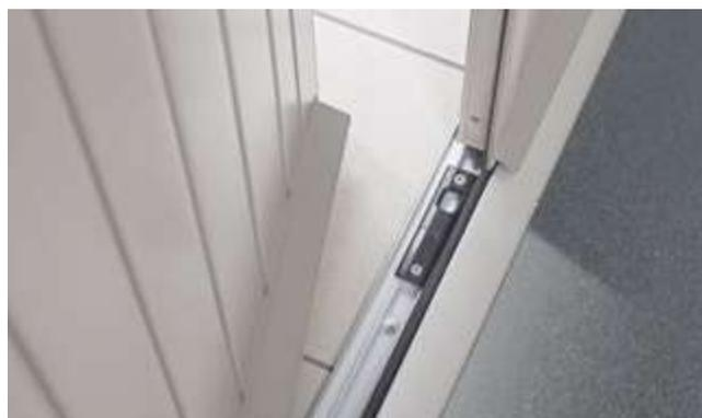
Seuil aluminium standard. Panneau avec jet d'eau filant en partie basse (ouverture intérieure)
