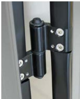
Gonds réglables vantaux repliables + joint anti-pince doigts
