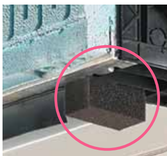
JOINTS DE PERMÉABILITÉ À L'AIR
