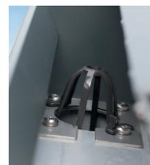
Gouttières équipées de crépines pour un bon écoulement des eaux pluviales
