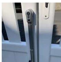
Verrou baïonnette déverrouillage manuel par clé
