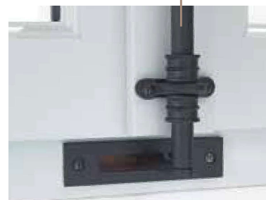
Fermeture par crochet s'associe à l'espagnolette.
