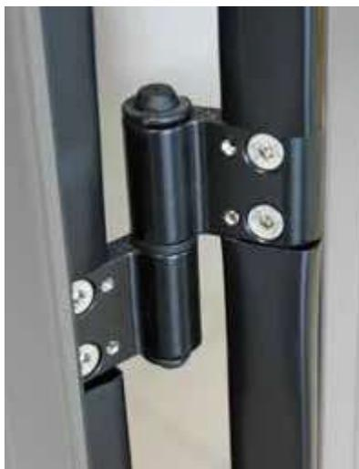
▲ Gonds réglables vantaux repliables + joint anti-pince doigts
